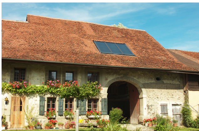
Capteurs solaires thermiques intégrés en toiture d'une ancienne ferme
