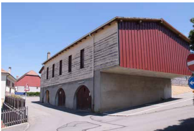
Datant de 1940-1941, l'ancienne salle, véritable « passoire thermique », avec sa partie sud en porte-à-faux qui n'existera plus dans la nouvelle salle.
